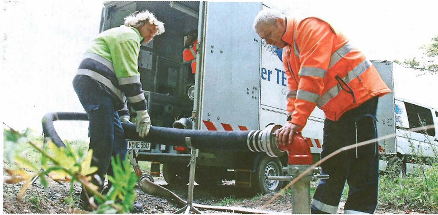
Ein Spezialunternehmen spült wie hier bei Heyersum das Rohrnetz in der Region.
